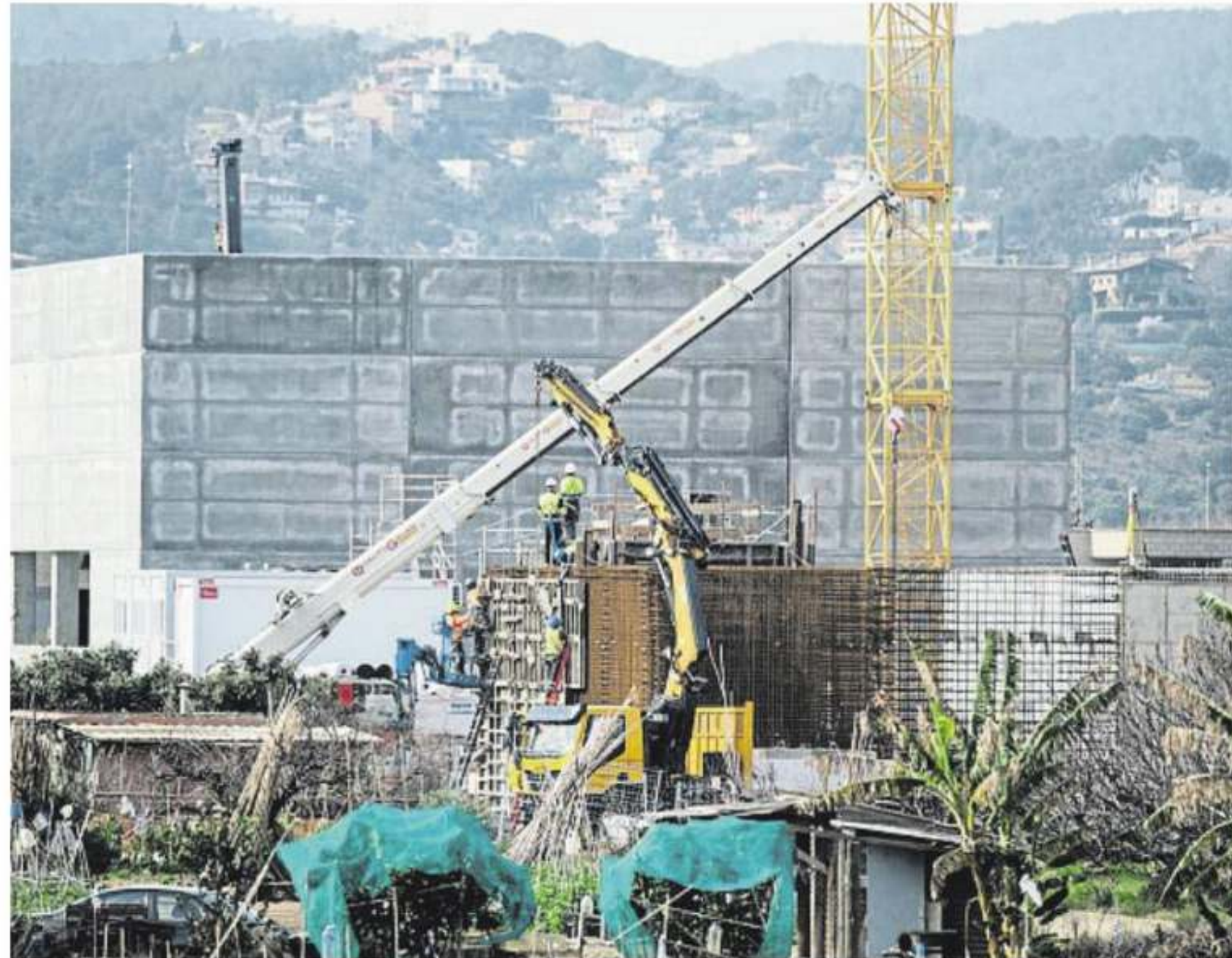
El equipamiento se encuentra situado entre cultivos del Parc Agrari y el río Llobregat
